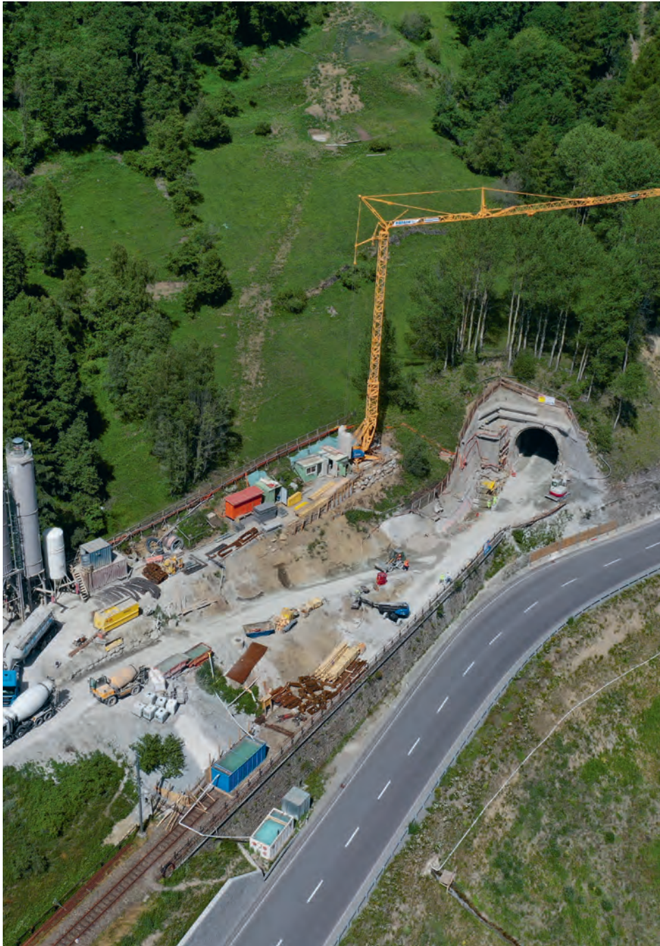
Die Costa AG baut auch für die Eisenbahn: RhB-Tunnelsanierung bei Garsun im Unterengadin in ARGE mit Walo.
