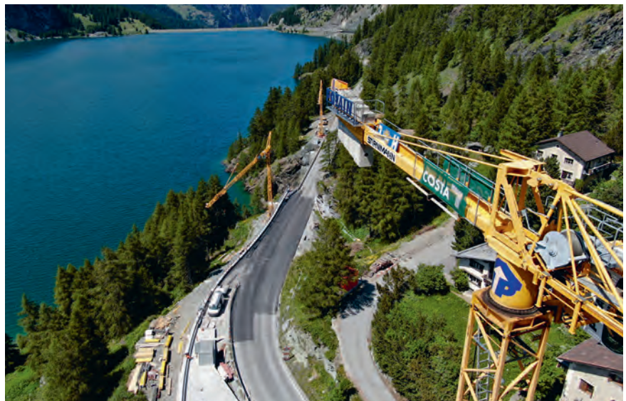
Kranführer haben eine schöne Aussicht: Strassenkorrektur bei Marmorera am Julierpass.
